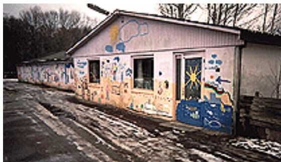
Hønehuset før renoveringen
