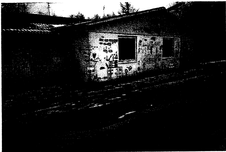
Bygningen, som vi har til huse i sammen med Vrå Amatør-teater, trænger til en meget kærlig hånd.
